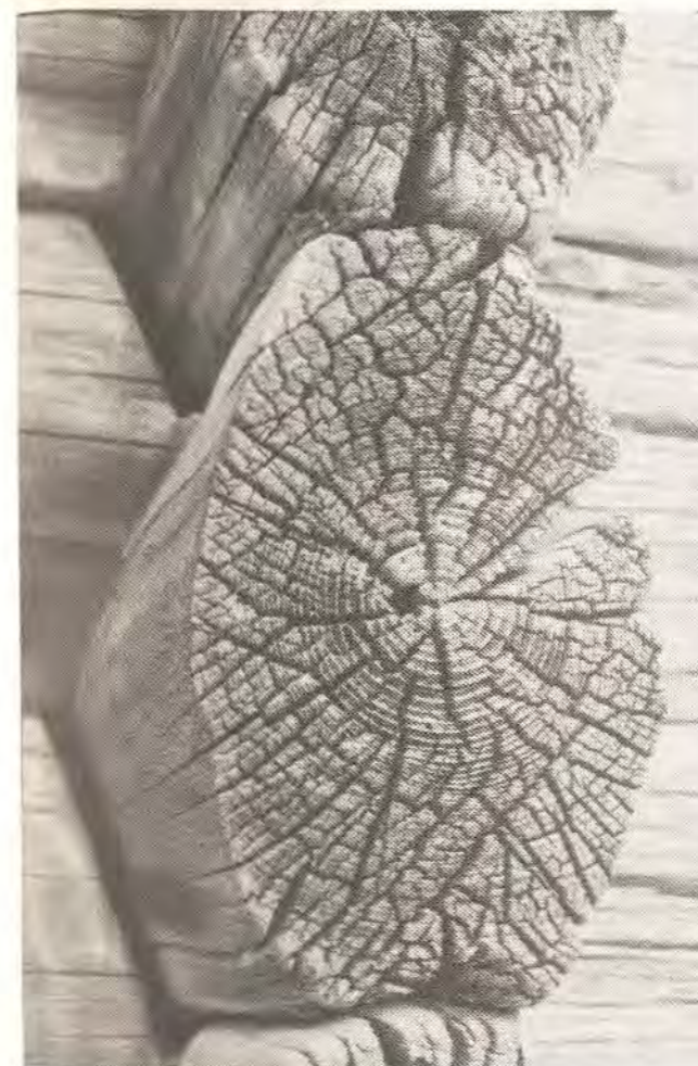
Figur 61. Älvdalens kyrkhärbre (1280-tal). Foto 1986. Timmervarven vilar på knutskallarna. Knutarna blir då
