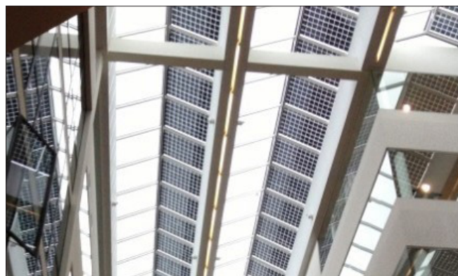
Semitransparenta solceller integrerade i tak (Atrium). Kontorsbyggnad "Tennet", Göteborg. Bild: Elsa Fablén.
