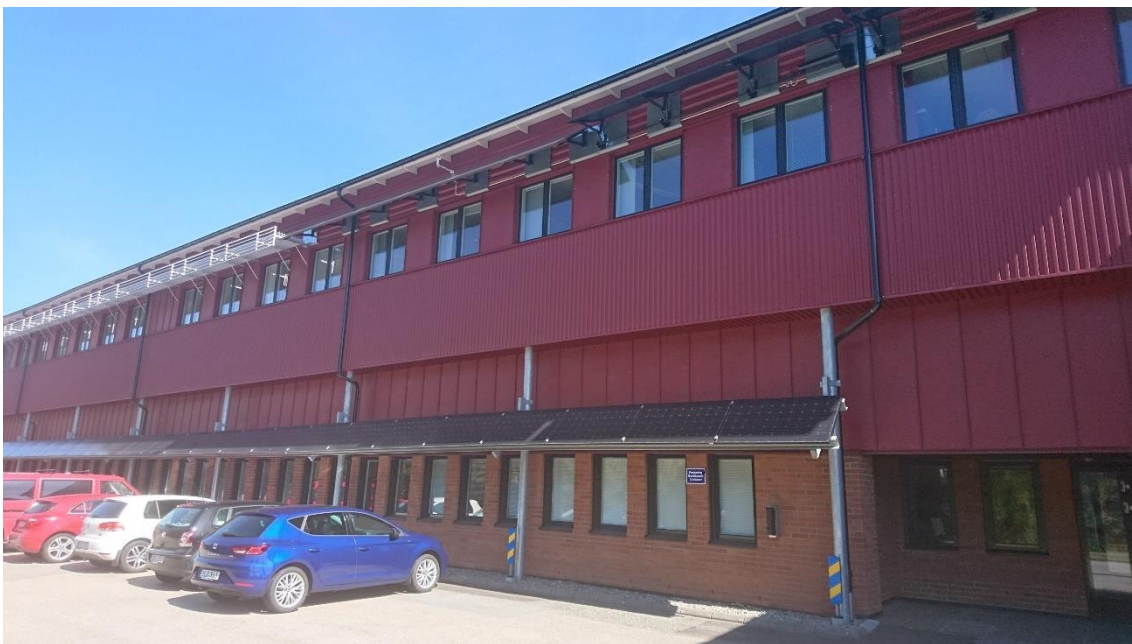
Figur 7. Solavskärmningen på bottenplanet vid RISE kontor i Borås har en topp effekt på 6,5 kW. Av bilden framgår hur intern skuggning från en avskärmning till en annan i vissa lägen kan ha väldigt stor inverkan på elproduktionsförmågan hos en elgenererande solavskärmning.
