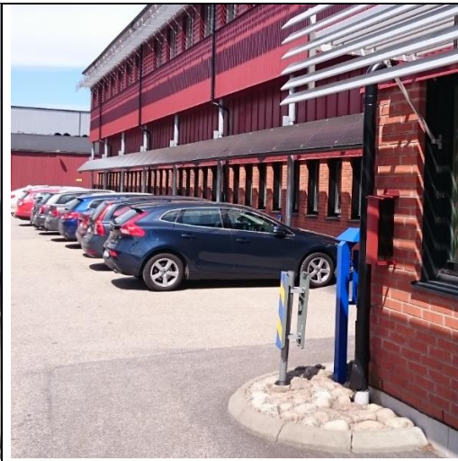
Figur 3 Solavskärmningsanläggningen med fast lutning på plan 1 vid RISE kontor i Borås. I förgrunden syns den konventionella avskärmningen byggd på aluminiumlameller.
