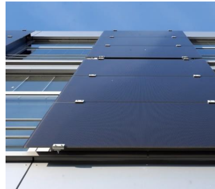
Figur 25 Skjutbara solavskärmningsmoduler av tunnfilm (glas/glas-laminat)
