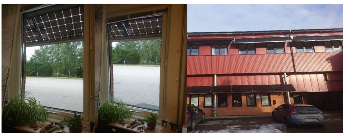
Figur 18 Den fasta horisontella avskärmningen på plan 1 med baksida av transparent tedlar. Vy från sittande och stående vid skrivbordet
