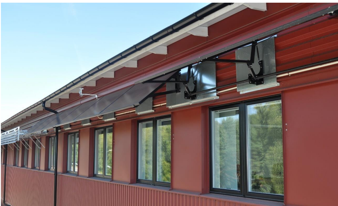
Figur 8 Solavskärmning på plan 2 vid RISE kontor i Borås. Fasta skärmar med solcellsmoduler i 40 graders lutning till vänster i bild och med rörliga moduler i 22 alternativt 58 graders lutning till höger. Längst till vänster den ursprungliga avskärmningen med aluminiumlameller, utan solceller.
