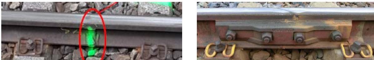
Abbildung 2: Beispiele für Diskontinuitäten auf der Fahrfläche: Schweißstelle (links) und Schienenstoß (rechts) (Fotos: DB Systemtechnik GmbH)
