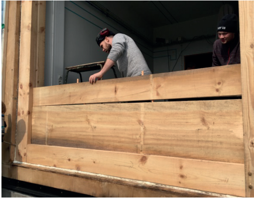
Figur 5. En bulhusvägg byggs upp på Energi- och Byggnadsdesign laboratorium, Lunds Tekniska Högskola.
