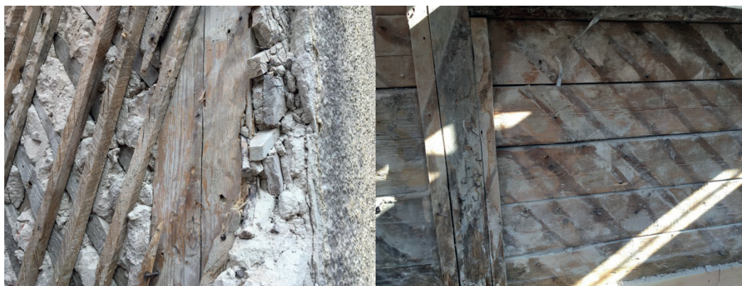
Figur 1. En reveterad bulhusvägg i Visby som renoveras. Till vänster reveteringen med träribbor, till höger syns yputsen.
