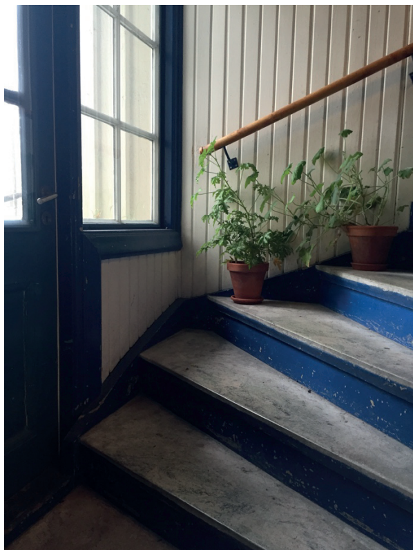
Figur 1: Banergatan i Göteborg, före renovering 2016
