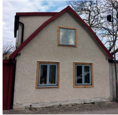
Figur 8. Gavelväggen i Visby efter genomförd renovering, våren 2018. Fönsterpartier har ännu ej byts ut.
