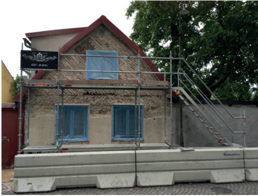
Figur 7. Renovering av en gavelvägg i Visby pågår, september 2017. Ytputsens har avlägsnats och träribborna är synliga.
