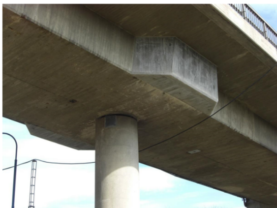
Figur 4.8.12 Förstärkning av tvärbalkar.
