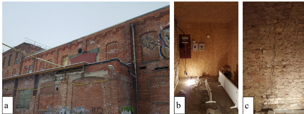
Figur 2. a) Industribyggnad från 1896 söder om Göteborg där ett testrum byggdes upp, b) Testrummet inuti byggnaden värmdes upp till cirka 23°C, c) Temperatur- och fuktsensorer monterades i väggen.
