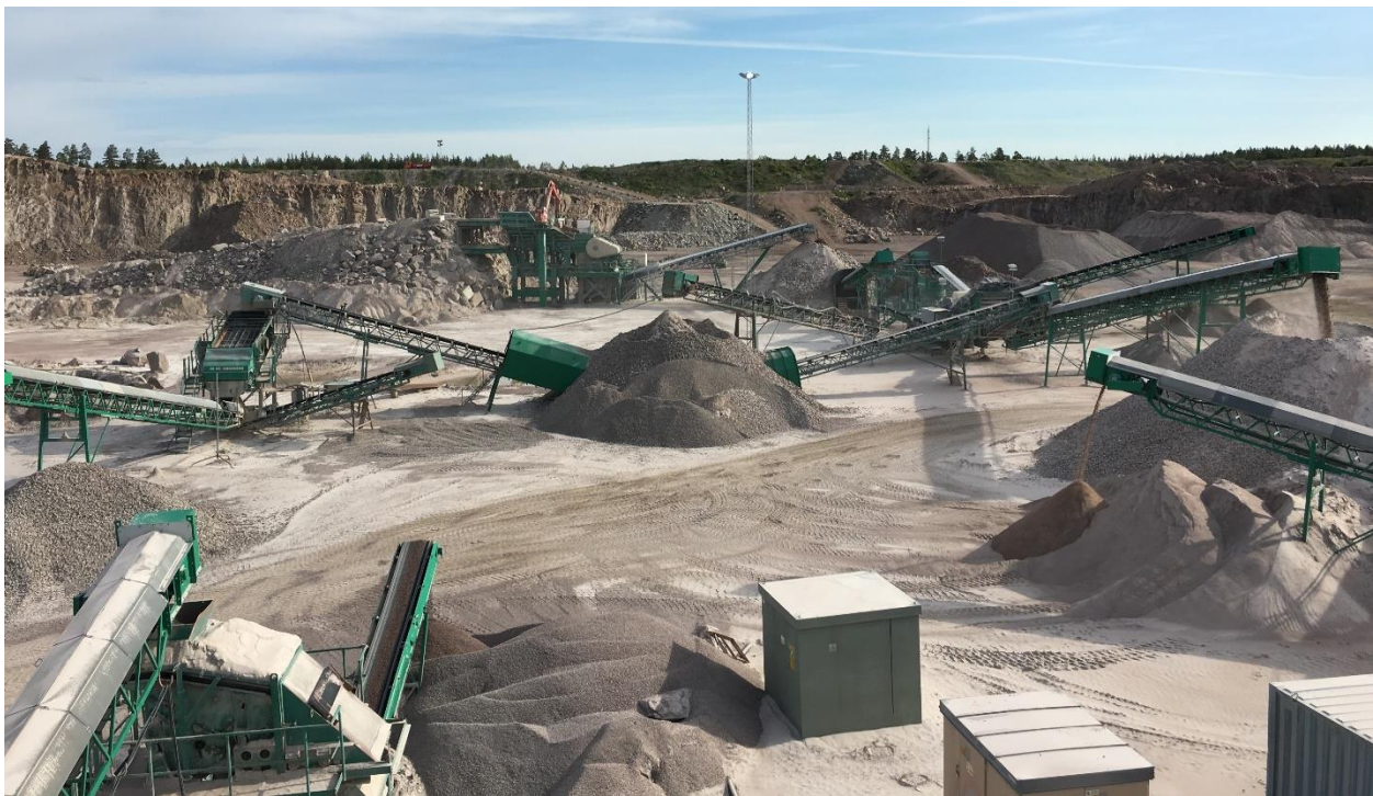
Figure 1. Two stage crushing plant. (Swerock, Vändle Bergtäkt)
