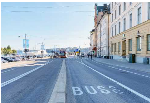
Mittplacerade busskörfält och refughållplats. Skeppsbron i Stockholm.
