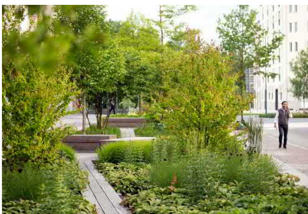
Växtbäddar som tar hand om dagvatten på Jaktgatan i Norra Djurgårdsstaden, Stockholm 2019.
