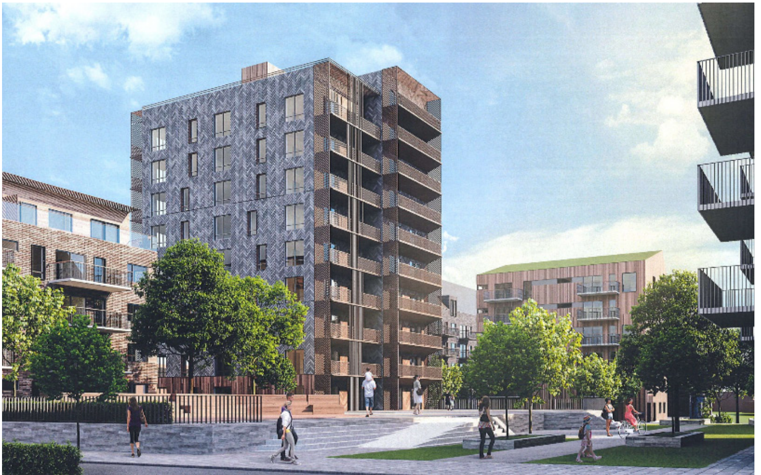
Vy över bostadshus och torg från markanvisningstävlingen i Kinna. Designteam: Erik Larsson Bygg och Krok & Tjäder.
