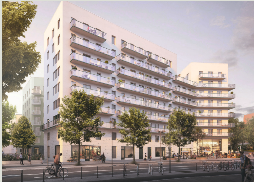
Projektet Hestur i Kista Äng har genomförts av beställaren ByggVesta, entreprenören AF-gruppen och stomleverantören Consolis Strängbetong. Totalt ingår 220 student- och hyreslägenheter med ett-fyra rum och kök. Bygget startade 2022 och inflyttningen startade i maj i år.
