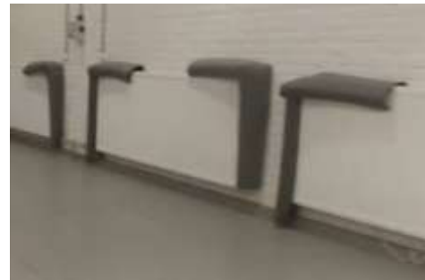
Bild 3 – Skyddspolstring installerad på radiatorer och järnbalkar.
