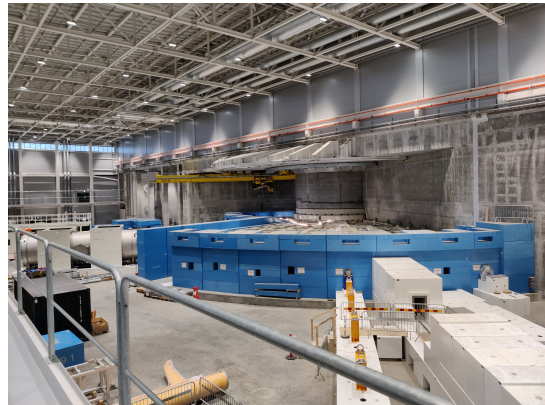
(d) ESS (under construction), Sweden
